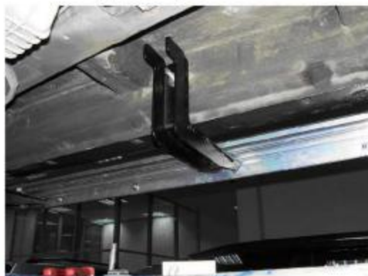
Рис.7 Установка среднего кронштейна
