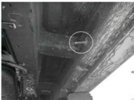
Рис.4 Установка закладной для среднего кронштейна
