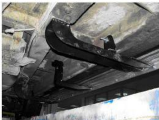
Рис.6 Установка переднего кронштейна
