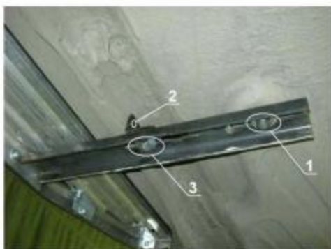
Рис.2 Установка переднего кронштейна
